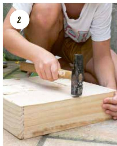
Lege die Rückwand auf die verleimten Kanten der drei Platten und lass den Leim 20 Minuten trocknen. Befestige die Platten zusätzlich mit je 4 Nägeln.
