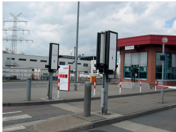
Portalmessanlage für Ein- und Ausfahrt mit Radioaktiv-Alarm
